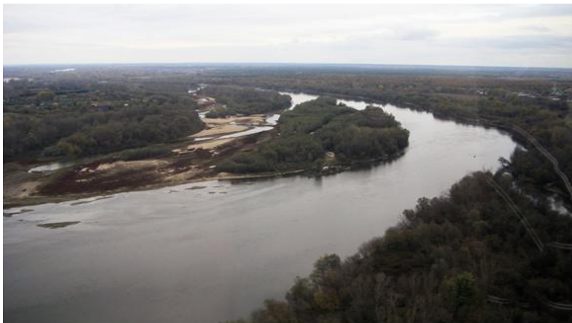
Fot. 5. Lokalizacja Łomianki Dolne (lewy brzeg).
